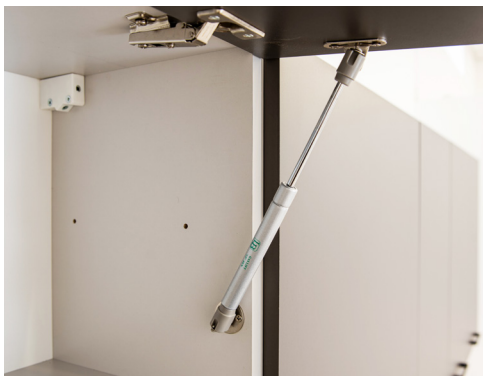
Podnośniki gazowe w szafkach uchylonych. Gas lifts in upper cabinets.
